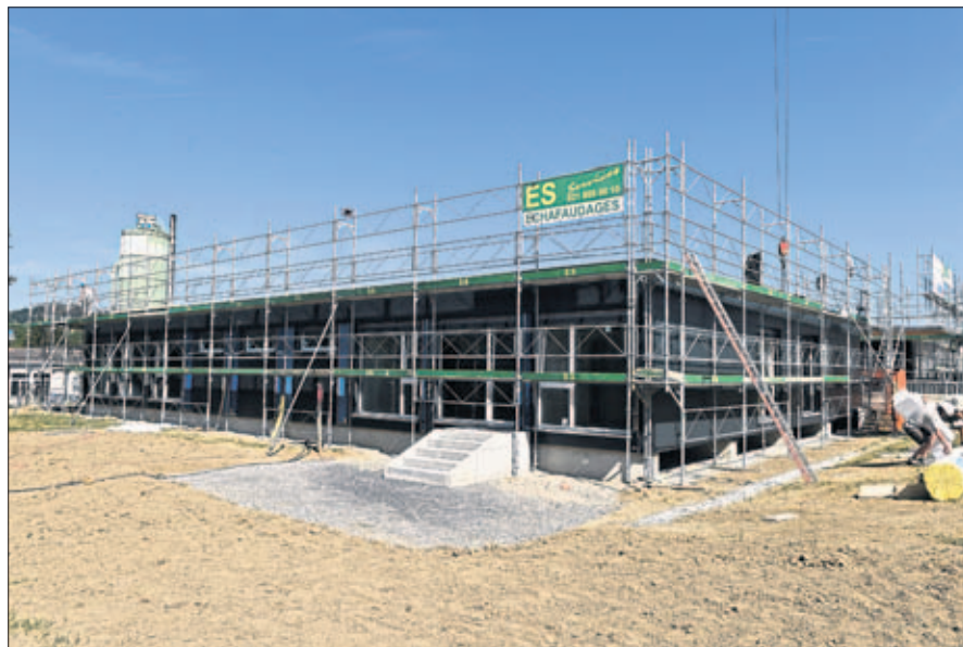
Moins de 48 heures plus tard, les 9 modules sont en place
