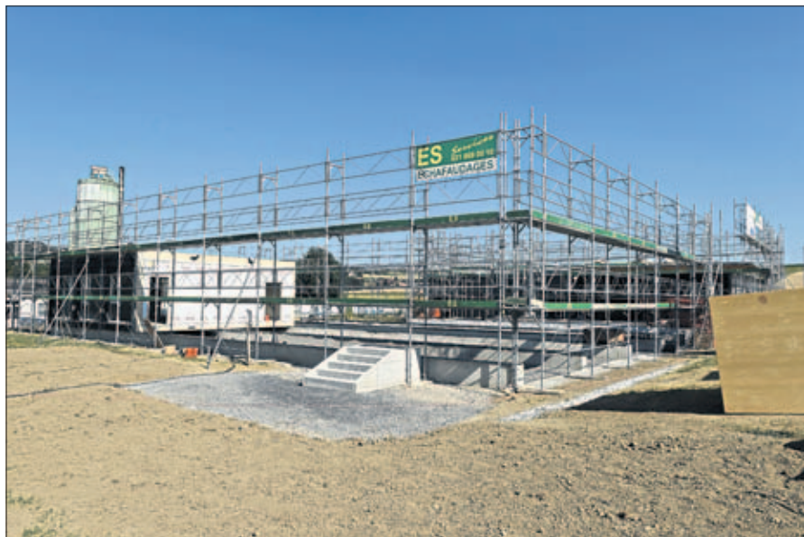
L'emplacement de la nouvelle garderie avec les deux premiers modules déjà en place
