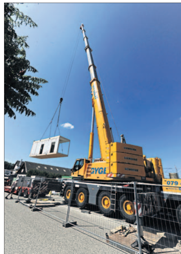
Levage et mise en place des différents modules avec leurs équipements déjà au complet (salles, cuisine, sanitaires, etc.)
