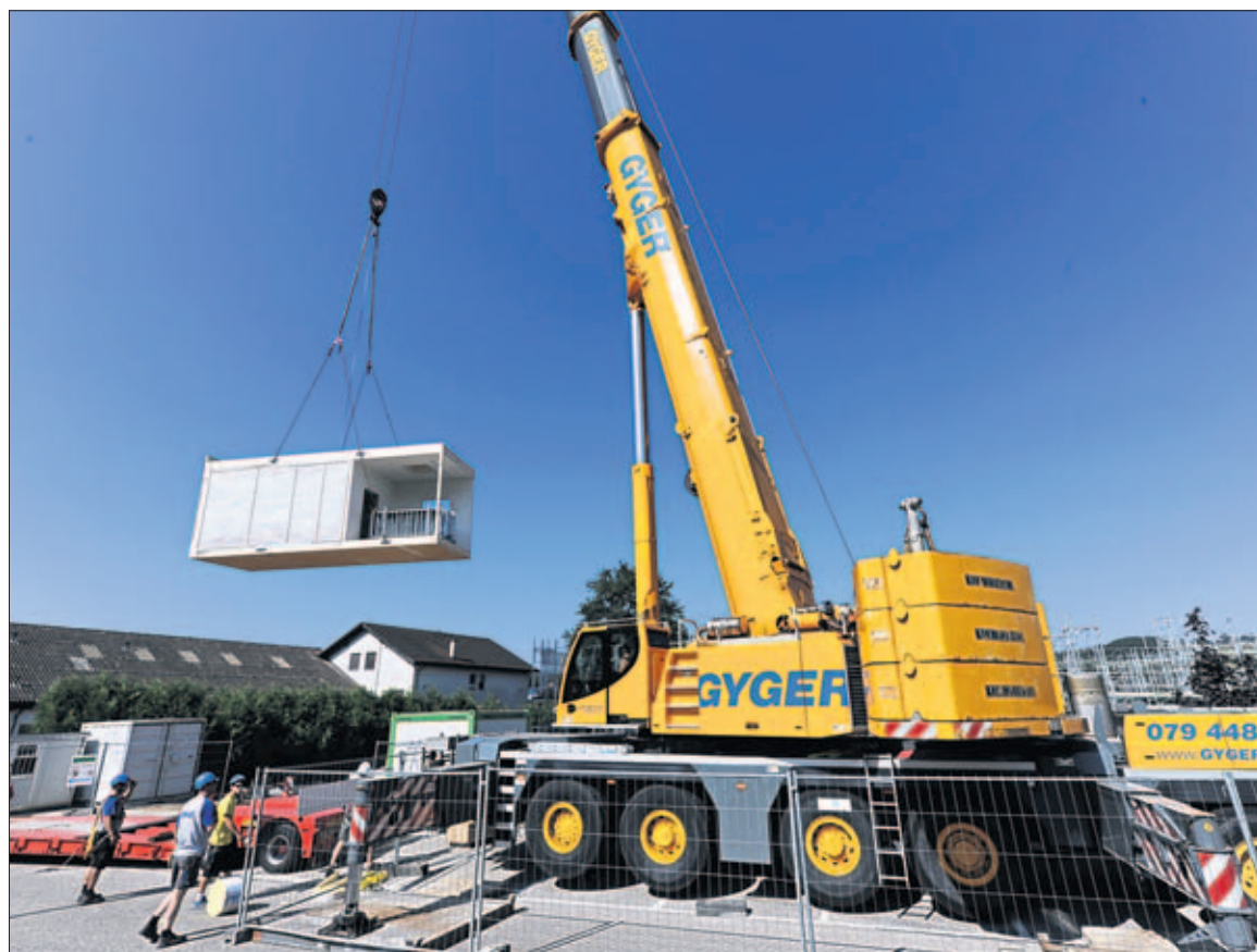
Levage et mise en place des différents modules avec leurs équipements déjà au complet (salles, cuisine, sanitaires, etc.)
