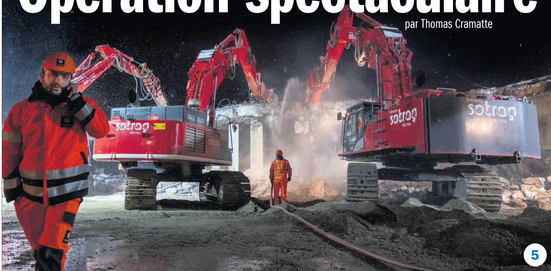
Quatre déchiçeteuses ont démonté le demi-pont construit en 1974
