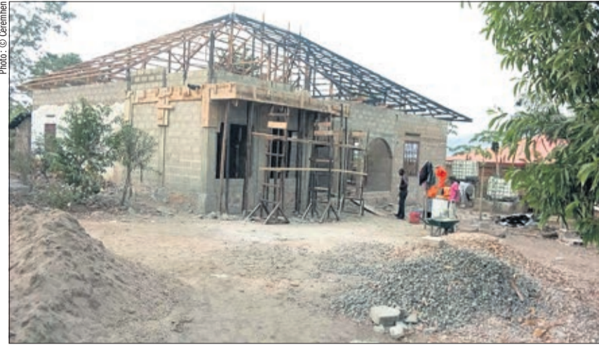
Nurserie: murs érigés, ancien toit démonté et charpente posée
