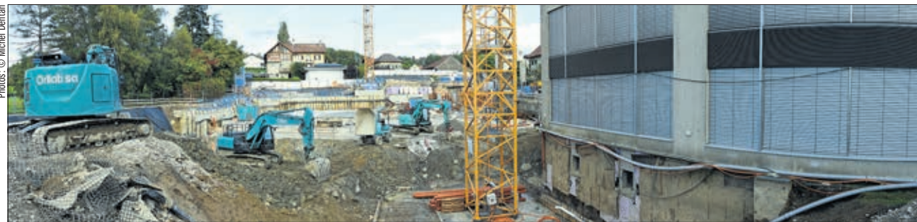
Les travaux spéciaux et les travaux de terrassement sont maintenant pratiquement terminés sur ce vaste chantier
