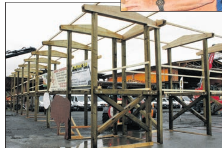
Eléments de la future passerelle du parc aux bisons du zoo de Servion
