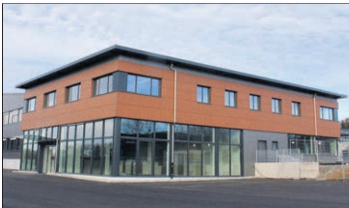
Bâtiment administratif site Palézieux
