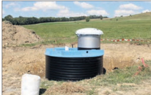
Pose de la chambre de pompage, le 4 septembre 2018
