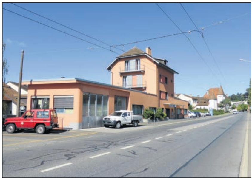
Bâtiment de l'APOL
