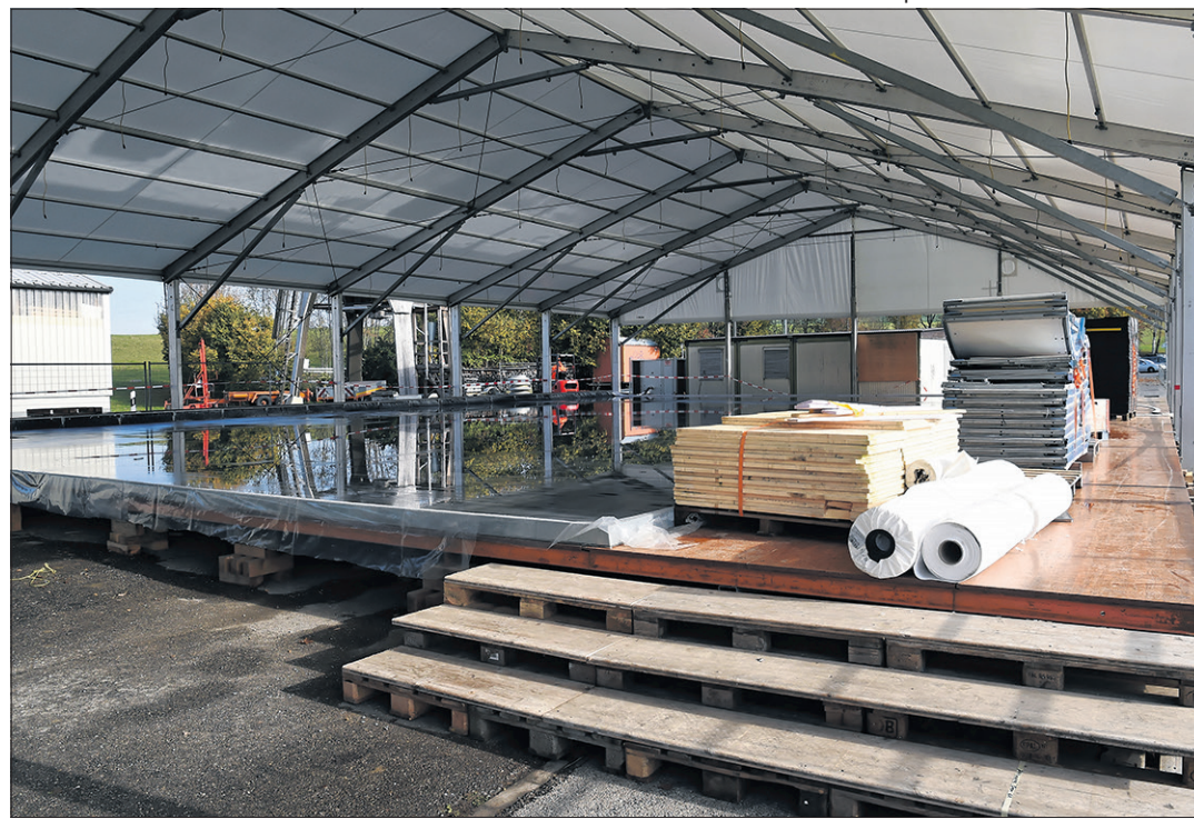
La patinoire en cours d'installation
