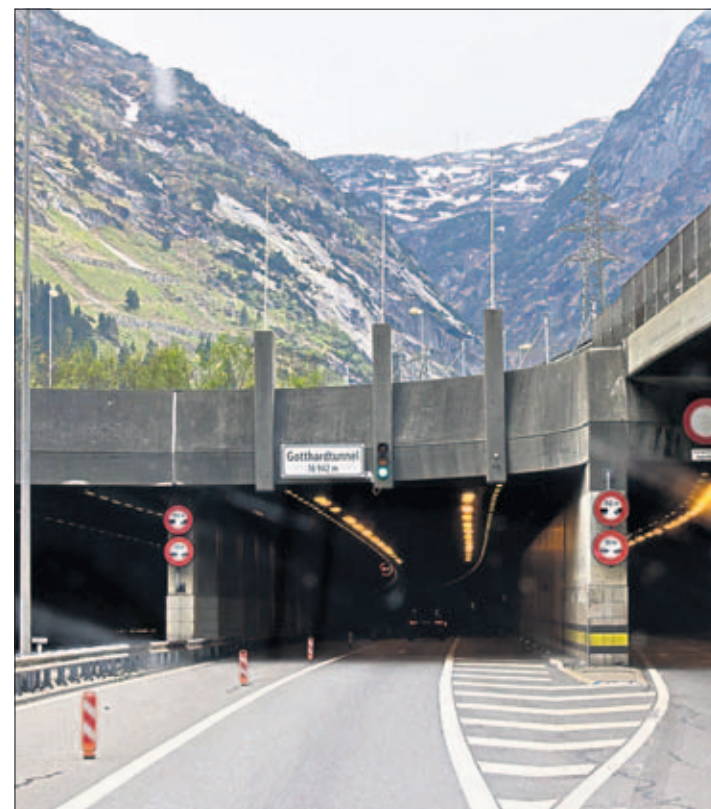
L'entrée du tunnel
